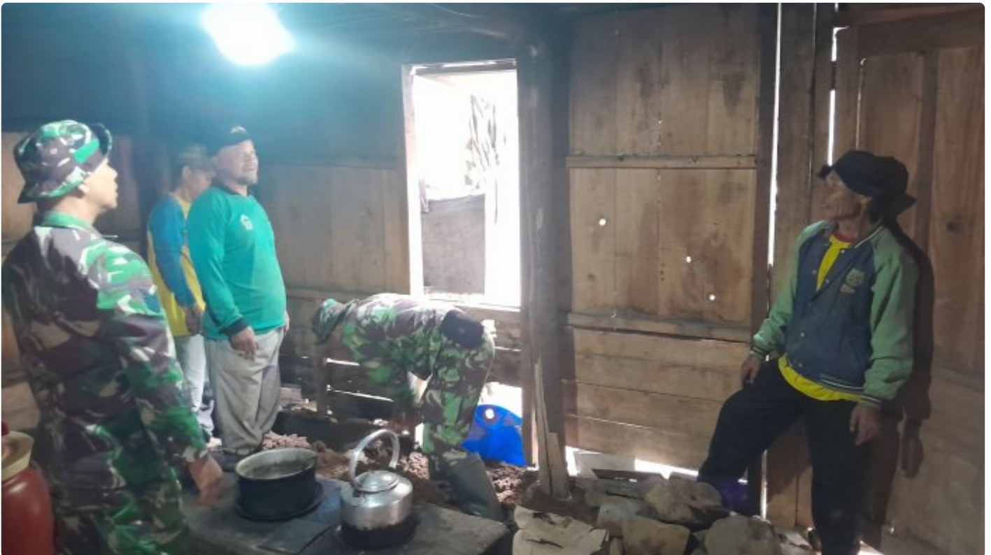
Perbaikan Rumah Bpk Tabroni dikerjakan Secara Gotong Royong Antara Satgas TMMD Dengan Warga
